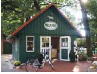
Melkhus Eckhof, Ehestorf, Quelle: TouROW
